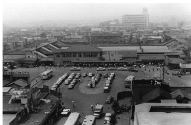
昭和40年 大宮駅東口 (写真提供:さいたま市)
